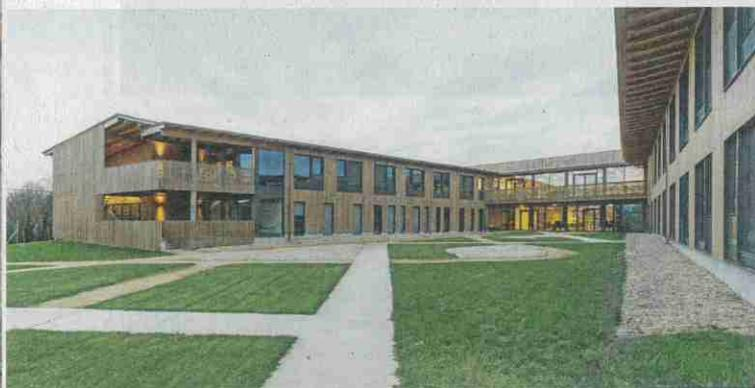
L'Ehpad des Aubrières à Saumur (Maine-et-Loire), livré en 2024, possède une ossature bois et des planchers en CLT.
