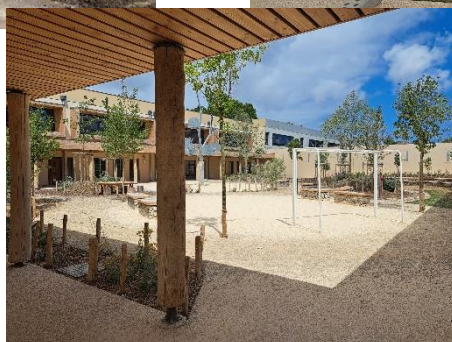
Cour d'école et préau désimperméabilisés
