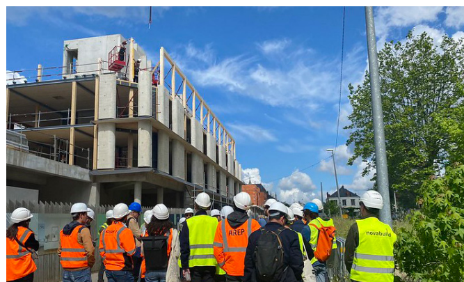
Visite du chantier MATERA - 23 mai 2024 - Nantes (44)
