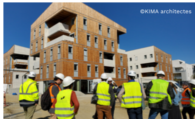
Visite de chantier Loggias de Clisson le 7 octobre
