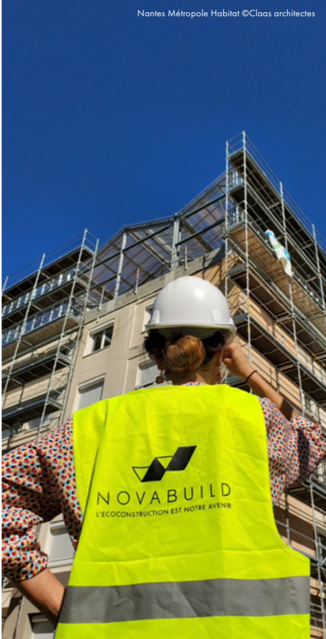
Visite du chantier Symbiose à Nantes le 14 Avril
