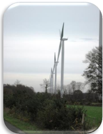
Ferme éolienne St Vincent des Landes
