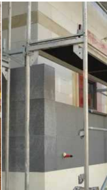
Maçonnerie parpaing + isolation extérieure
