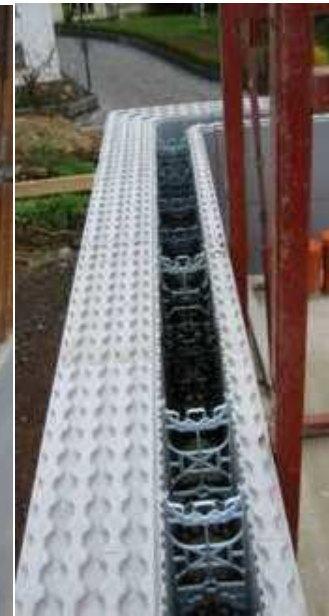
Béton + blocs de coffrage
